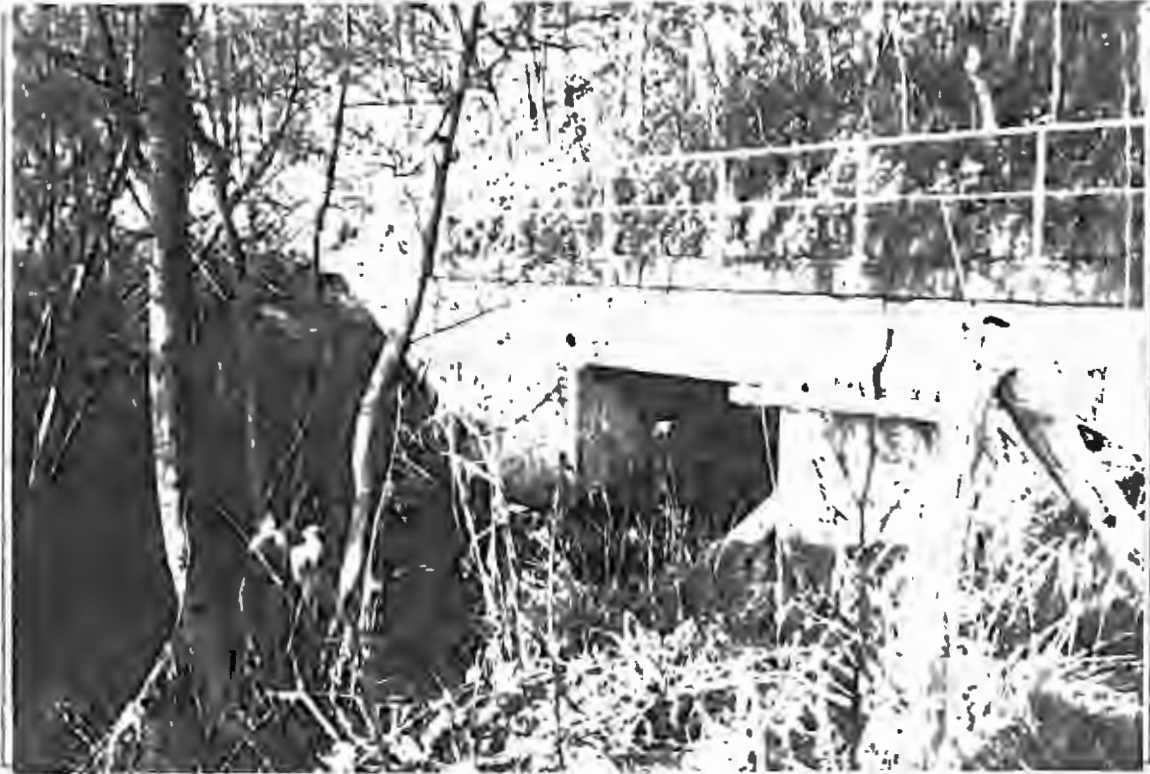
Photo 21: Hohenfelder Mühlenau unterhalb Straßendamm L 165
